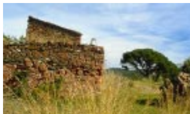
Ruinas de la Masia de Can Bruguera
