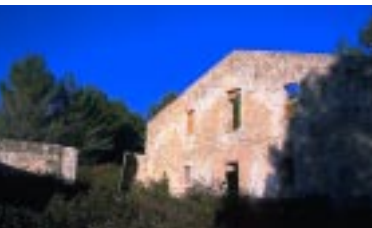
Ruinas de la Masia de Can Beco
