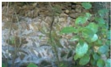
Muro construido en forma de «espiga de peix»
